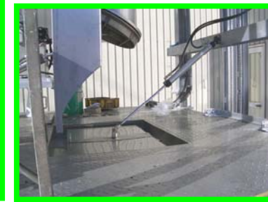
ホッパーより処理機への生ゴミ投入口
