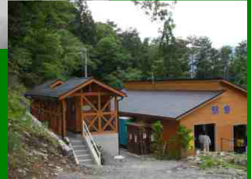
トイレと駅舎
